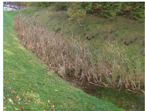
Bemessung: Mindestvolumen von 20m<sup>3</sup> soll zu Kontrollzwecken offen ausgeführt werden, maximaler Wasserstand soll 50cm nicht überschreiten, naturnahe Gestaltung durch Bepflanzung und Formgebung.
